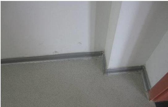
墙角无蜘蛛网，墙面干净无污痕
