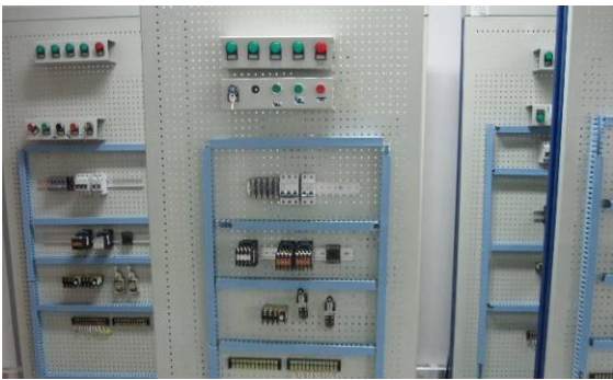
接线板上无杂乱导线
