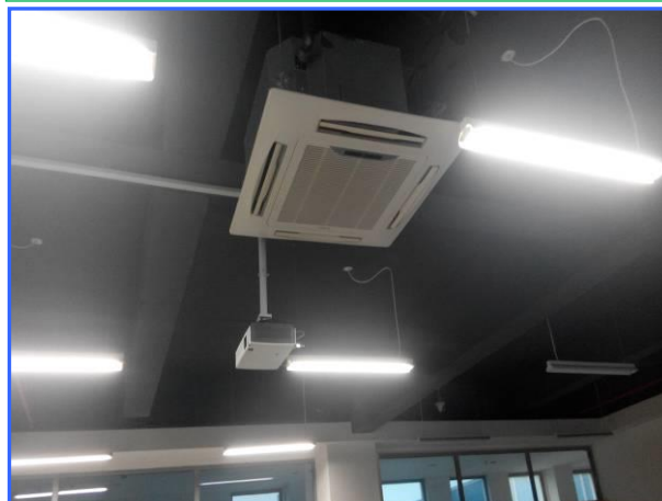
下课后关闭空调和照明。
